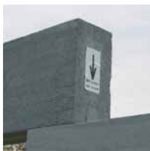
Uložení nenosného překladu
