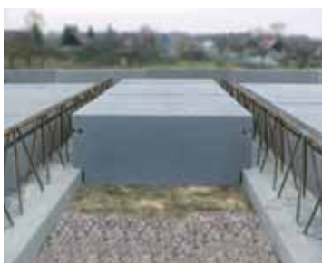
Ukládání stropních vložek
