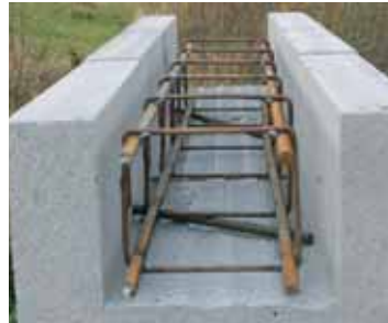
Ztužující věnec z U-profilů bez tepelné izolace
