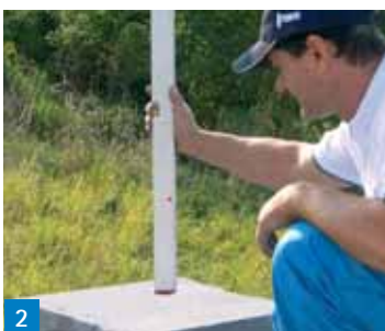
2 Výškové osazení tvárnice
