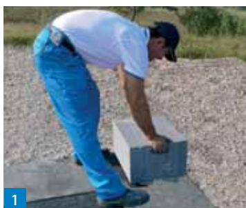
1 Osazení rohové tvárnice
