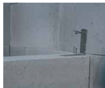
Kotvení nenosné příčky
