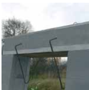
Obr. č. 1 – zabezpečení uložení nosných překladů proti převrnutí
