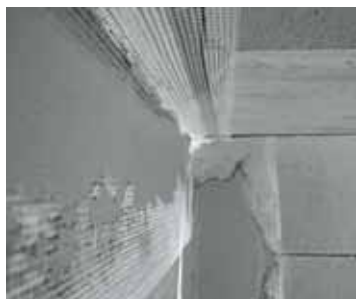
Přesíťkování napojení nenosné příčky
