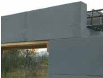
Nosný překlad z U-profilů bez tepelné izolace
