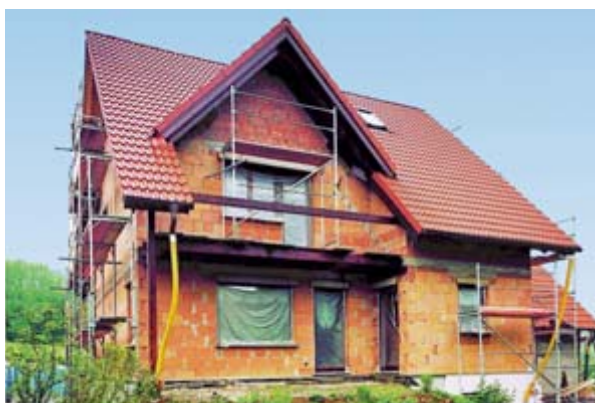
Stav domu před zateplením (obr. 10)
