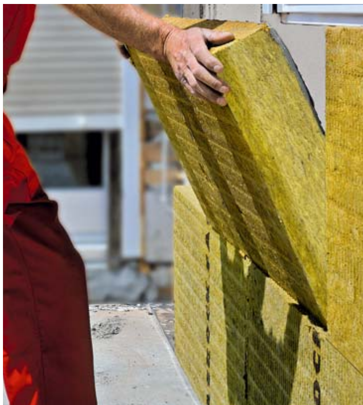
Montáž ETICS s deskami Frontrock MAX E (obr. 14)
