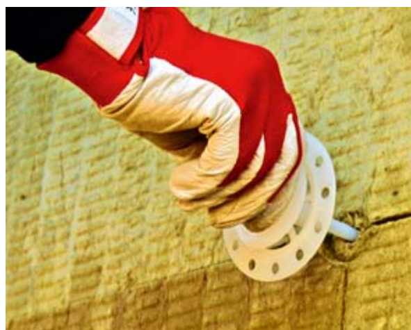
Osazení hmoždinky s rozšiřovacím talířkem (obr. 22)
