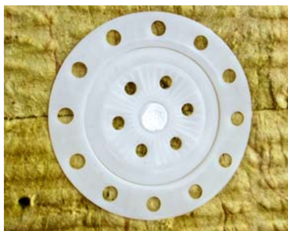
Správně osazená mechanická kotva s termoizolační zátkou. Talířek lícuje s povrchem desky Frontrock MAX E (obr. 24)
