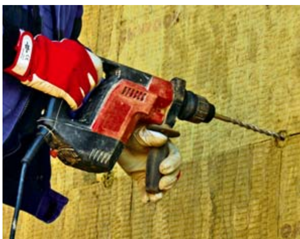
Důležitost kolmého postavení vrtáku k podkladu (obr. 21)
