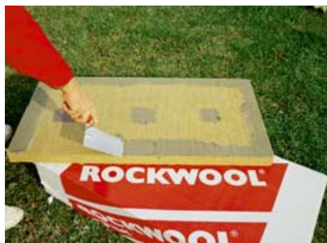
Aplikace lepidla na desku Frontrock MAX E (obr. 16)
