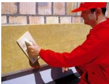
Provádění izolace Rockwool (obr. 11)
