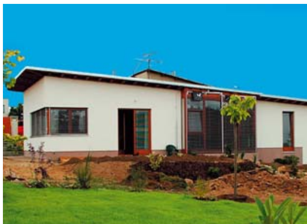
Příklady fasád zateplených pomocí desek Rockwool (obr. 8, 9)
