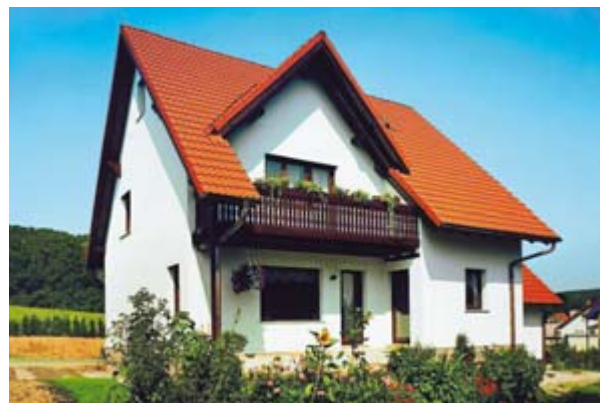
Konečný stav domu po zateplení (obr. 13)
