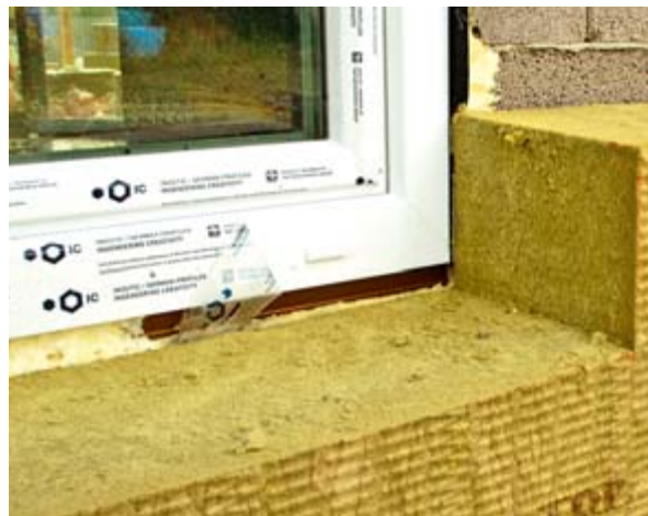
Způsob pokládky desky v místě otvoru (obr. 20)
