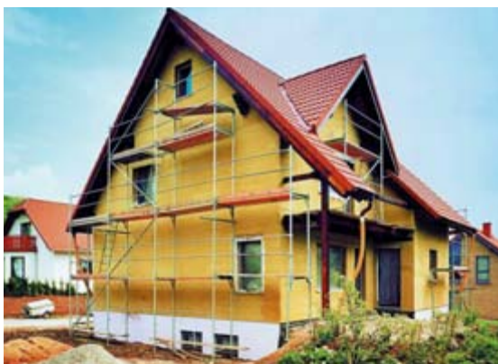
Provádění izolace Rockwool (obr. 11)
